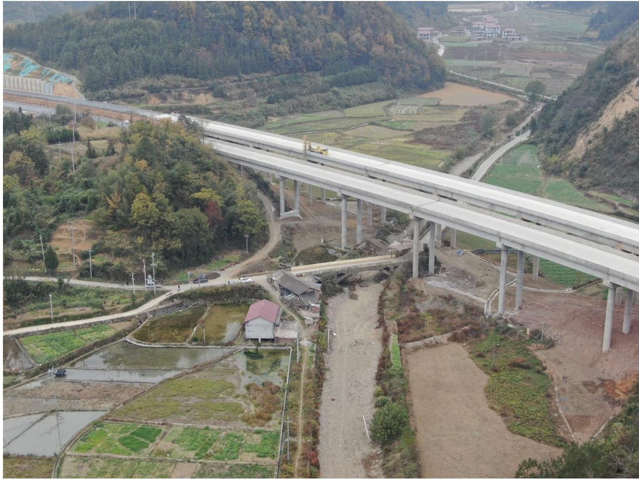
图1.2-4 田湾镇杨梅坳跨河桥河段
